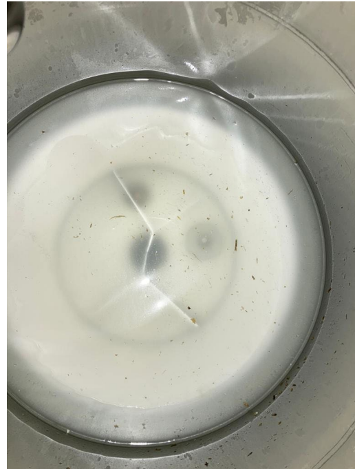
Foto 17: Vuil restwater in de melkontvangst na spoeling wijst erop dat de drainage en reiniging onvoldoende was.
